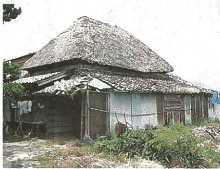
〈修復前〉30年間、物置小屋として使われていた家屋
